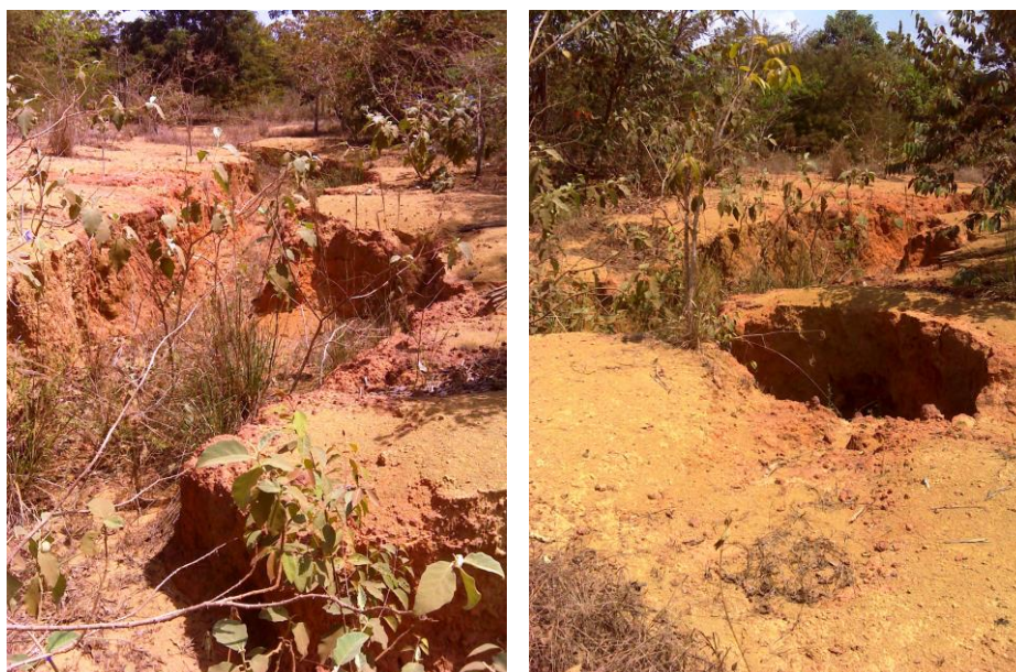
Figura 12: Presença de erosão evidenciada na unidade de amostra 01 no plantio de mudas durante o monitoramento realizado em maio de 2015 nas áreas em processo de recuperação pós lavra de bauxita em Paragominas-Pa.
